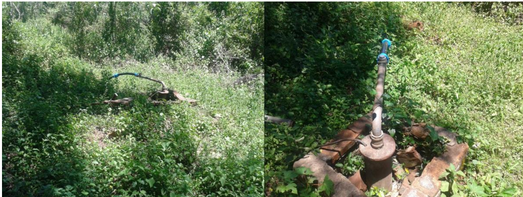
Figura 16: Poço de abastecimento de água na localidade de Alto Uruguai Fonte: Bios Consultoria Ambiental, 2013
